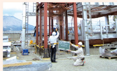
施設事業(現場監理)
