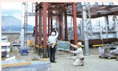
施設事業（現場監理）
