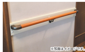
安全対策に「転ばぬ先の手すり」
